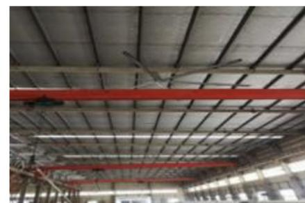
原来包装车间采用 20 台挂墙固定风扇进行降温，20 台合计功率 16KW，公司更换为大型工业吊扇，每台功率 1.5KW，合计 6 台，总功率 9KW，每天节约 70 度电，工作时间为 4 月 -10 月，年节约电量 14,700 度。
