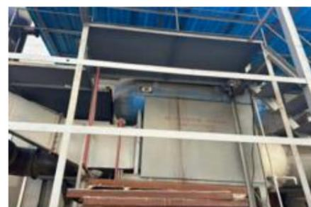
公司购入余热利用锅炉，利用 3 个余热利用锅炉收集烟气热温为镀锌车间助镀槽加热，可将助镀槽水温加热到 60-65℃，平均月节约天然气 2 万 m<sup>3</sup>，年节约天然气 24 万 m<sup>3</sup>。
