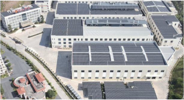
白渡厂区一期4.7兆瓦屋顶分布式光伏发电项目实景图
