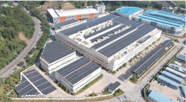
白渡厂区二期4.42兆瓦屋顶分布式光伏发电项目实景图
