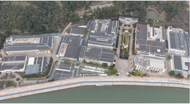
雁洋总部6.57兆瓦屋顶分布式光伏发电项目实景图
