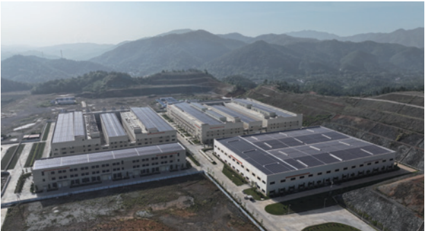
嘉元时代10.88兆瓦屋顶分布式光伏发电项目实景图
