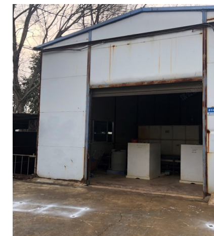
荧光探伤废水处理站
