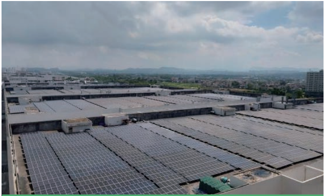
天津基地光伏发电项目(新建生活区)
