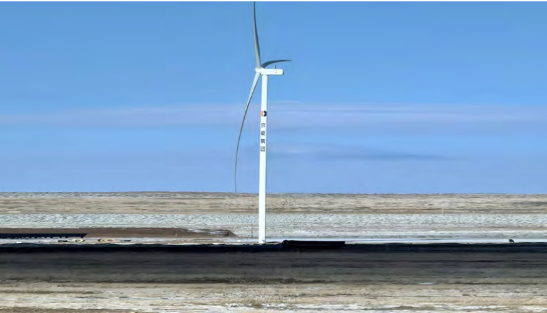
锡林能源 35.5MW 风电制氢一体化及全额自发自用新能源替代厂用电项目全容量并网发电
