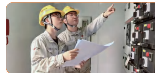
龙滩水力发电厂光伏场站运维人员开展隐患排查工作
