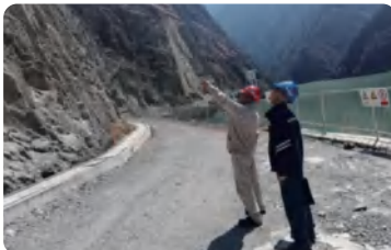
工人排查库区边坡隐患
