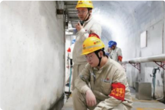
运维人员现场检查厂房排水情况
