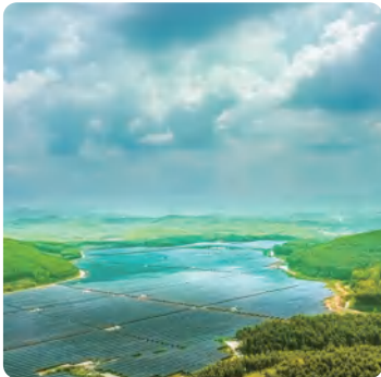
桂冠电力合山公司“风光火储多能互补”综合能源利用
