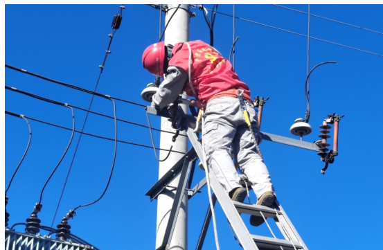
变电站春季检修
