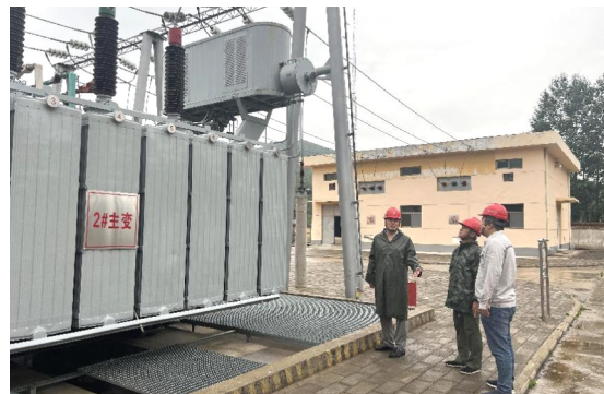
变电站防汛检查
