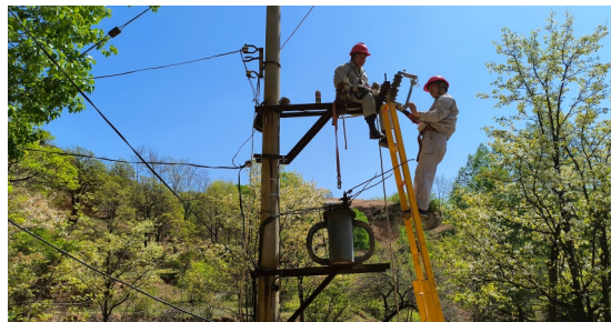
为村民安装变压器、配电箱
