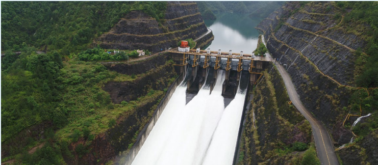
▲ 瓯江小溪上骨干水利枢纽——滩坑水电站开启 4 扇溢洪道闸门有序预泄洪
