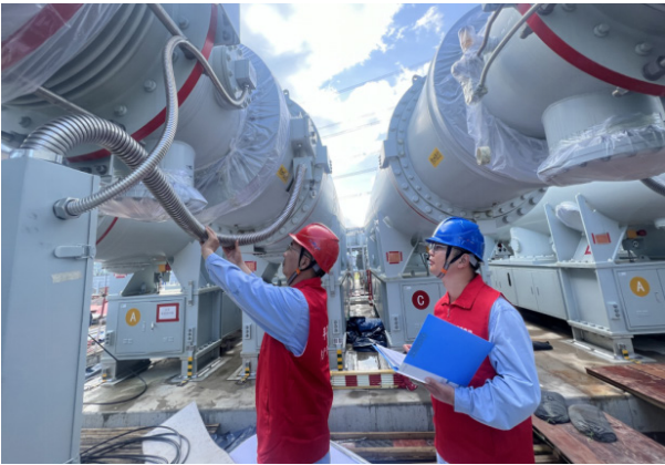
▶ 安装现场巡检
