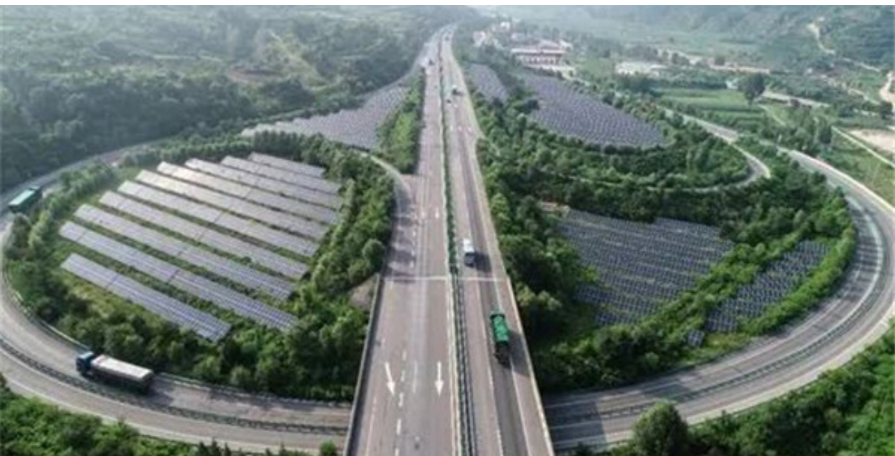
沈海高速公路赣榆至灌云段改扩建工程
