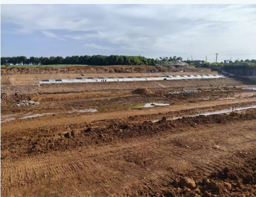
襄阳市襄州区红水河水库除险加固工程建设现场
