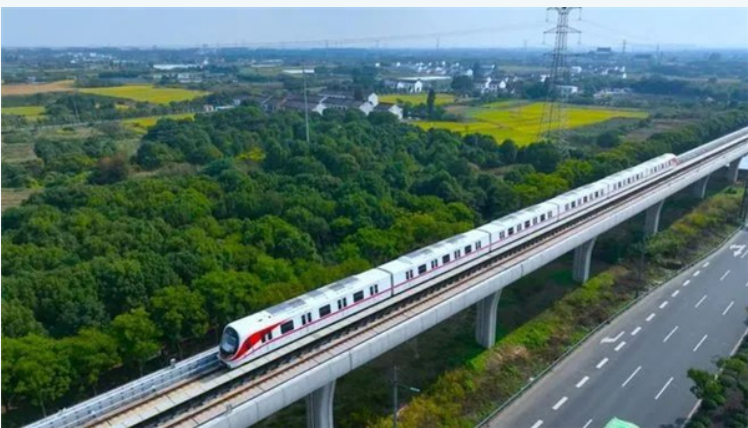
无锡至江阴城际轨道交通工程 S1 线
