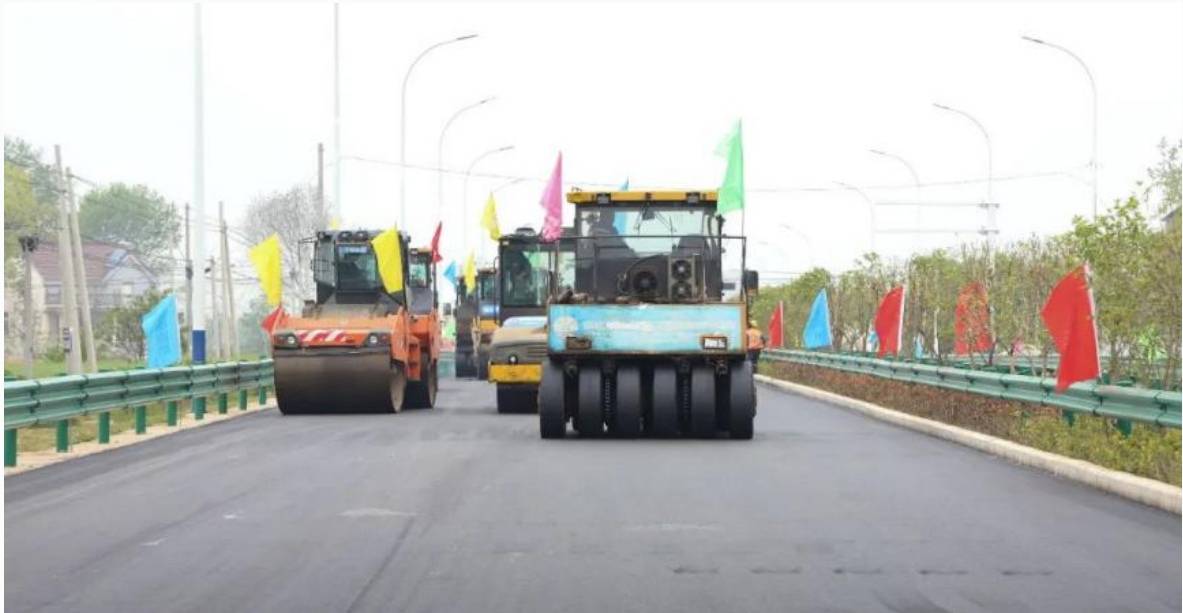
阳德路施工现场
