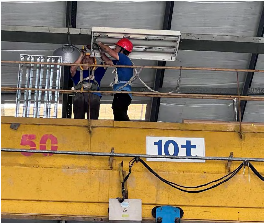
广日电梯为车间更换节能照明设施
