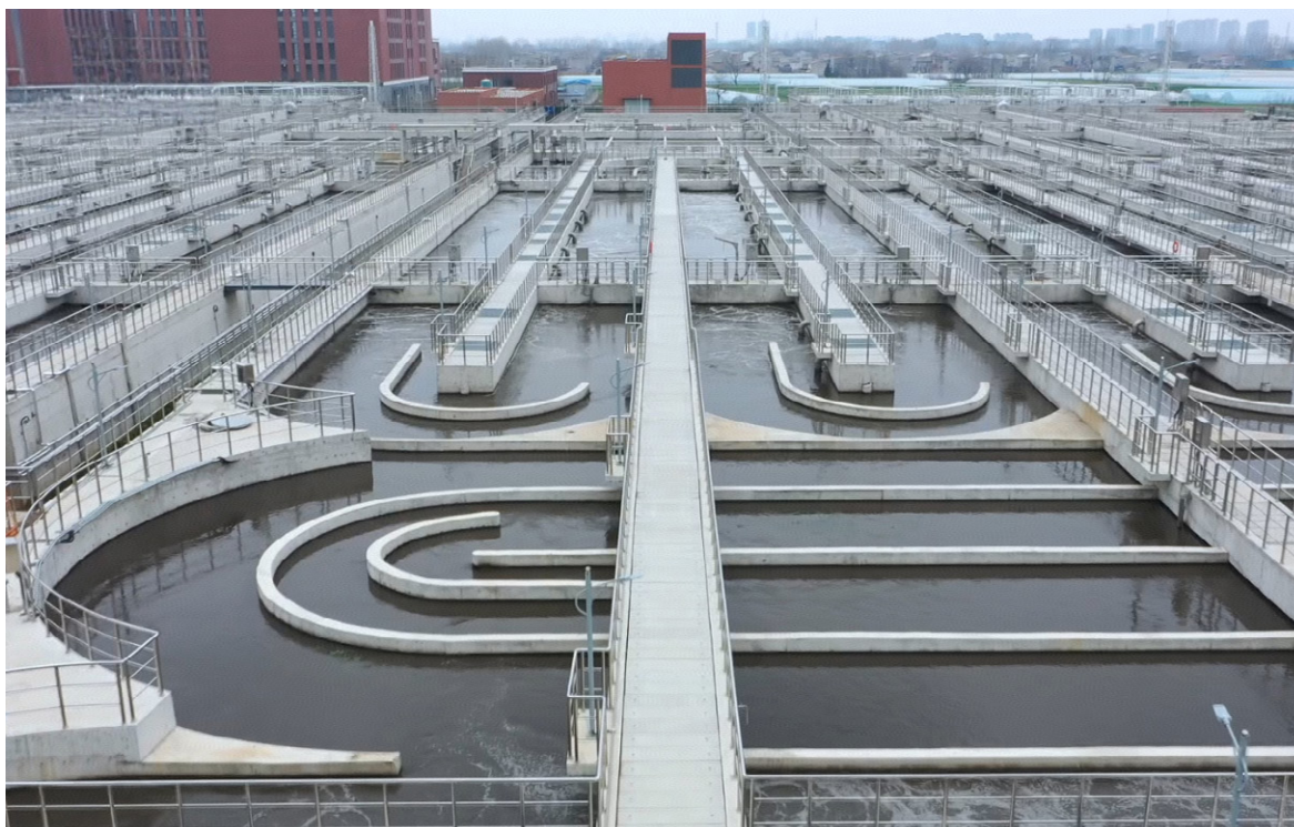
郑州新区污水处理厂二期工程水区土建施工二标段项目
