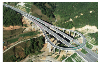
临双高速回转车道
