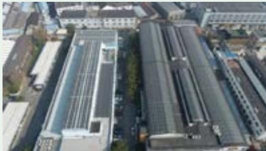
屋顶安装分布式光伏发电系统
