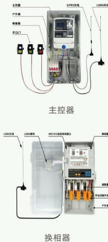
公司以电力电子技术为核心，依托最新电力电子功率器件及AI智能算法，研发了新一代智能换相装置，可在低压配网中实现单相负荷自动换相，动态优化平衡变压器负荷分配，大幅减少台区中变压器和线路损耗。
