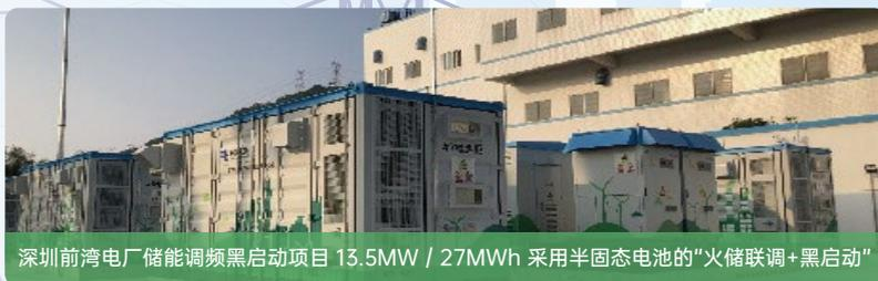
深圳前湾电厂储能调频黑启动项目 13.5MW / 27MWh 采用半固态电池的“火储联调+黑启动”
