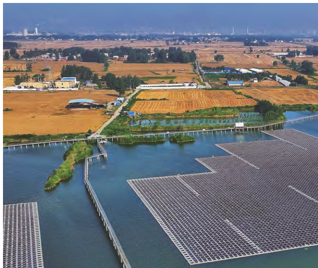
▲ 本行安徽省分行支持的绿色金融项目——宿州水上漂浮式光伏电站
