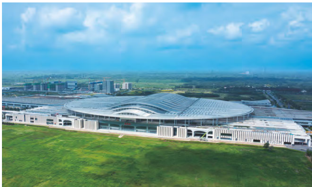
▲ 本行支持的京雄城际铁路项目
