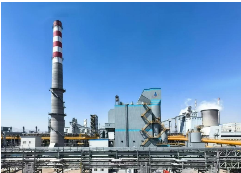
图1 内蒙古君正化工新建300万吨/年焦化炉龙净干式超净 + 烟气超低排放项目
