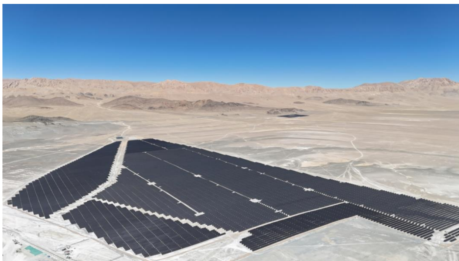
图 2 西藏拉果错源网荷储一期 200MW 光伏+504MWh 储能系统项目
