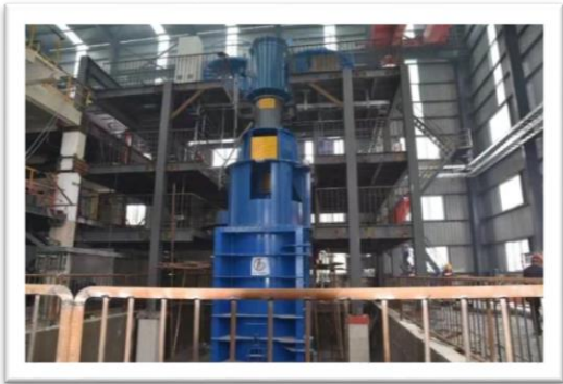
图：金安矿业超纯铁精粉项目现场
