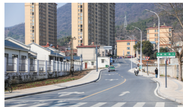
维西路拓宽改造工程
