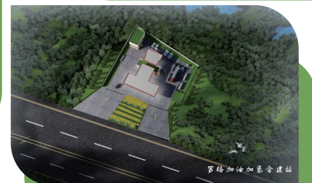
中石油全国第一座加油加氢合建站示范项目——罗格加油加氢合建站
