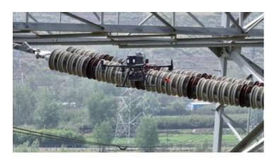
图: 自主研发的机载绝缘子零值带电检测装置在 330kV 线路上成功试点运行
