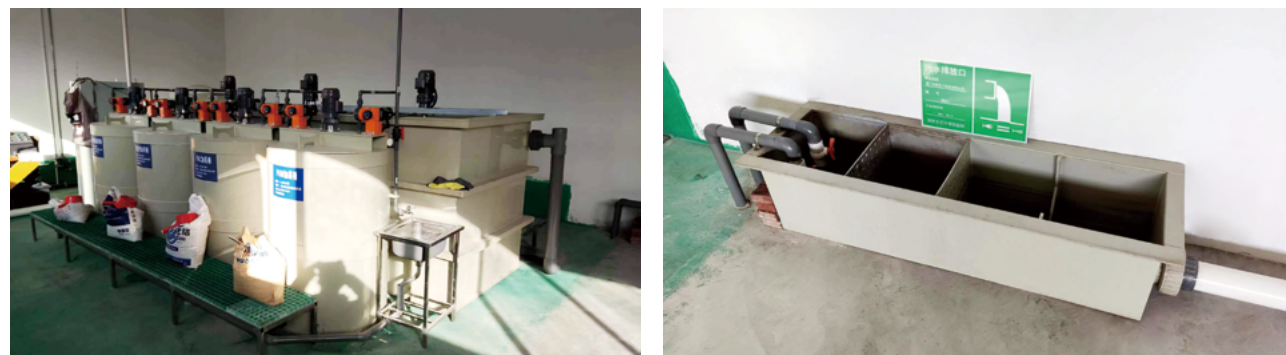
华联电子 2023 年投运废水处理系统，日处理工业废水量可达 60 吨。
