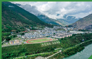
苗尾电站道路边坡治理成效
