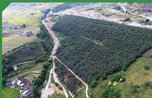
苗尾电站丹玛壩渣场边坡植被恢复
