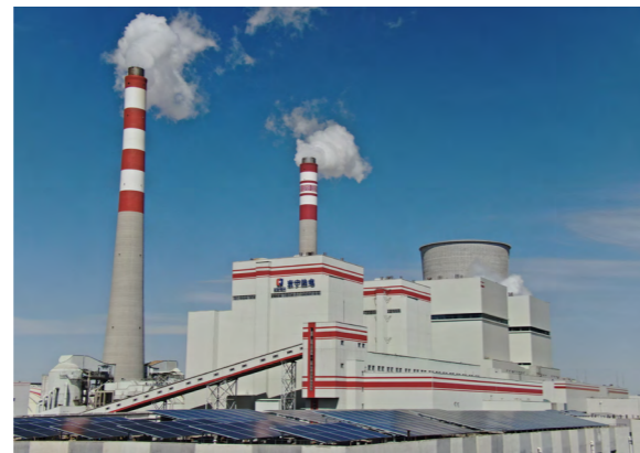
京宁热电二期项目
