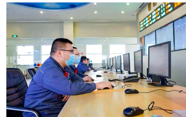
涿州京源强化电网调控运行
