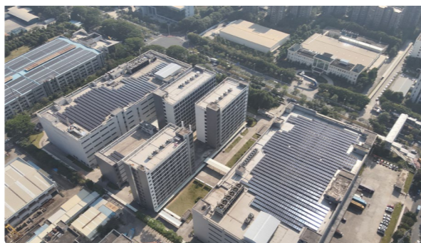
东莞第一制造中心三四期光伏
