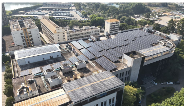
东莞第一制造中心一二期光伏
