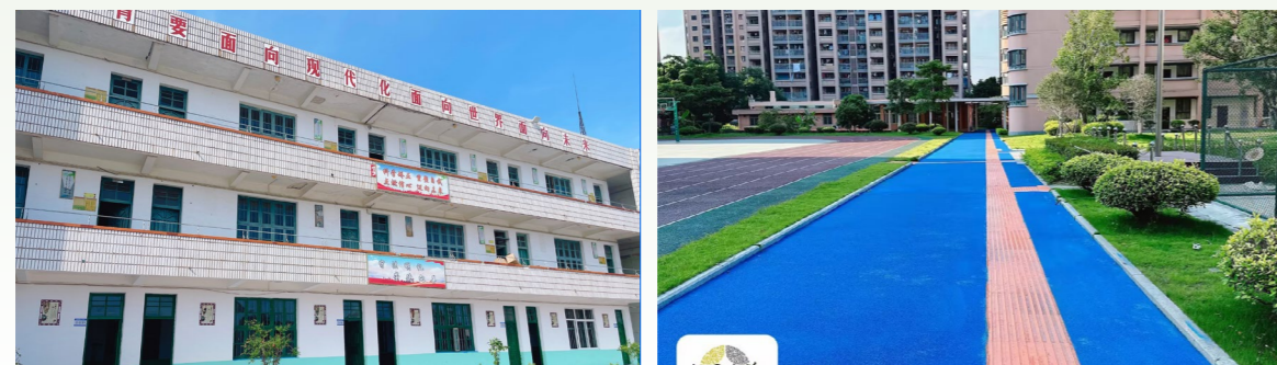
修缮后的学校外墙和跑道
