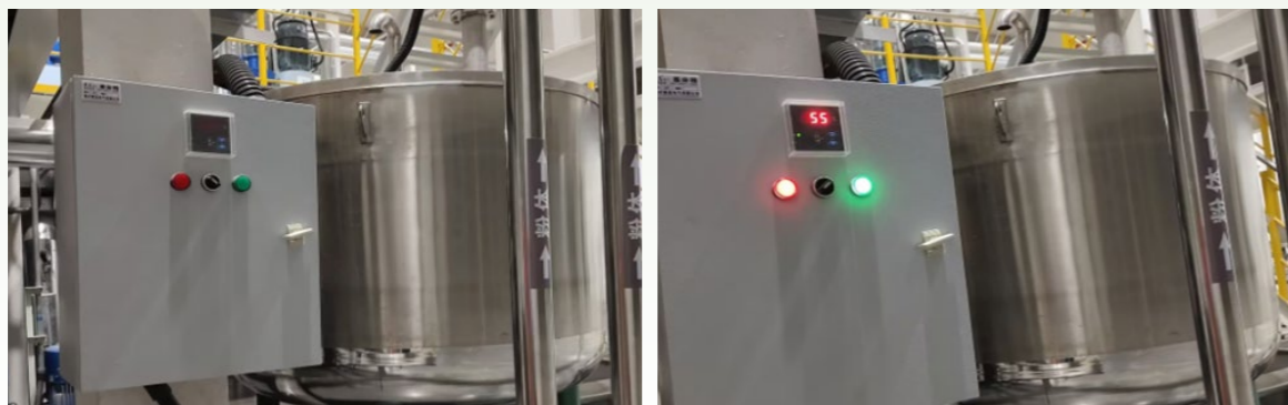
三棵树安徽工厂美缝剂电加热保温改造前后对比图
