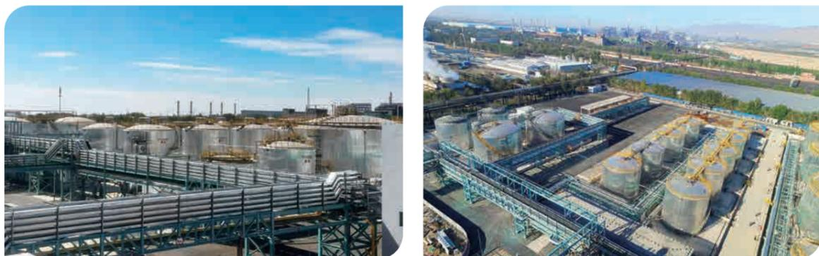
**包钢庆华合成氨项目投入使用。**合成氨项目是包钢庆华实现转型升级、创新发展，有效贯彻落实“碳达峰、碳中和”和“能耗双控”目标的重要工程。该项目于2020年9月动工，利用甲醇弛放气中的氢气和空分装置富余的氮气来生产液氨，可以实现资源再利用并导入下游产业，具有高利用率和低污染排放的优势。合成氨装置采用变压器吸附制氢工艺，将原料气中的一氧化碳、二氧化碳等杂质组分脱除，排出氢气与中压氮气混合，经过压缩机提压至10兆帕以上，再利用合成塔将氢气与氮气反应生产出质量符合国家标准的液氨，设计产能为每年7万吨。
