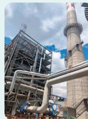
包钢股份轨梁厂践行绿色发展理念、推动减污降碳，实施两条线加热炉超低排放改造项目。通过前期对两座加热炉烟气排放监测情况及炉体自身情况进行分析，1<sup>#</sup> 线加热炉采用低氮燃烧和固定床干法脱硫技术，2<sup>#</sup> 线加热炉采用尾部烟气固定床干法脱硫和 SCR 中低温选择性催化还原脱硝技术，经过对两座加热炉进行“量体裁衣”式改造，加热炉超低排放改造项目投运即达到环保排放标准。
