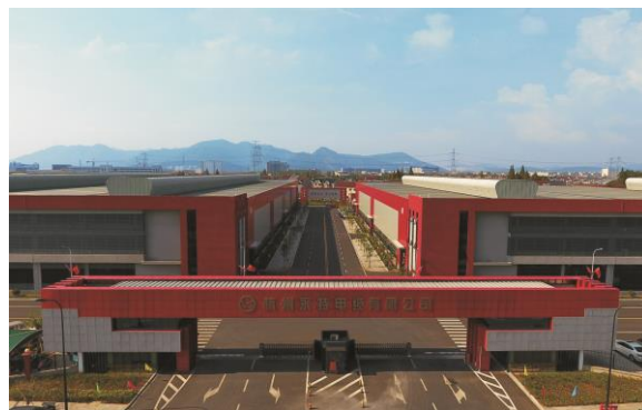
杭电股份导线和特种电缆基地位于杭州市富阳区东洲新区，占地面积 170 亩，主要生产全系列铝合金架空导线和 1kV 及以下低压特种电缆。
