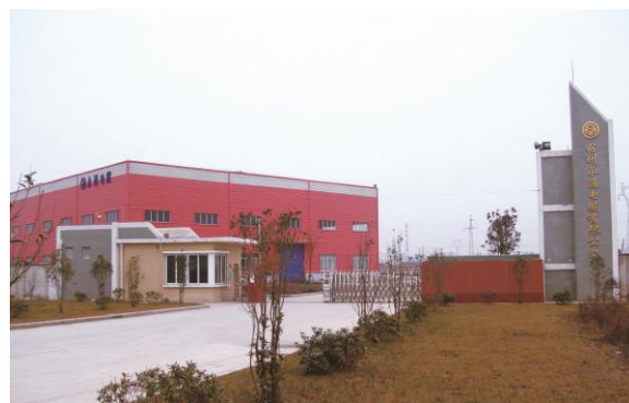
宿州永通电缆有限公司是杭电股份全资子公司位于安徽省宿州经济技术开发区，占地面积 70 亩，作为杭电股份矿用电缆生产基地，主要生产橡套和控制电缆等。
