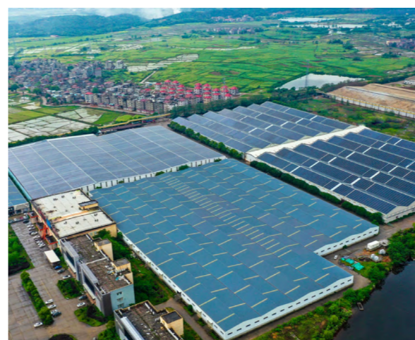
2023 年 9 月 27 日，江西新能源高安一期、二期合计 95 兆瓦屋顶分布式光伏项目全容量并网
