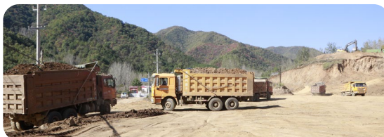
↑ 移民新区全面开工建设
