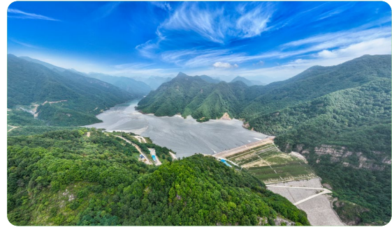
↑ 王家坪尾矿库
