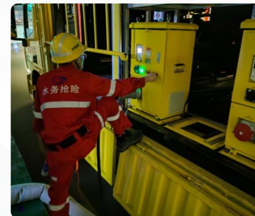
应急抢险队员采用应急发电设备启动排水泵
