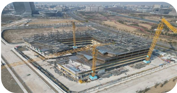
临港综合性研发中心建设项目
