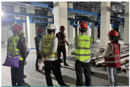
总包每日安全巡检
