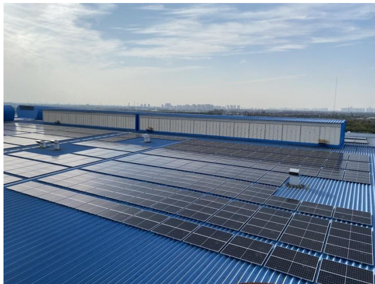
宝之云罗泾数据中心光伏项目一期工程局部
