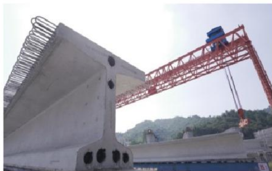
装配式桥梁上部结构
