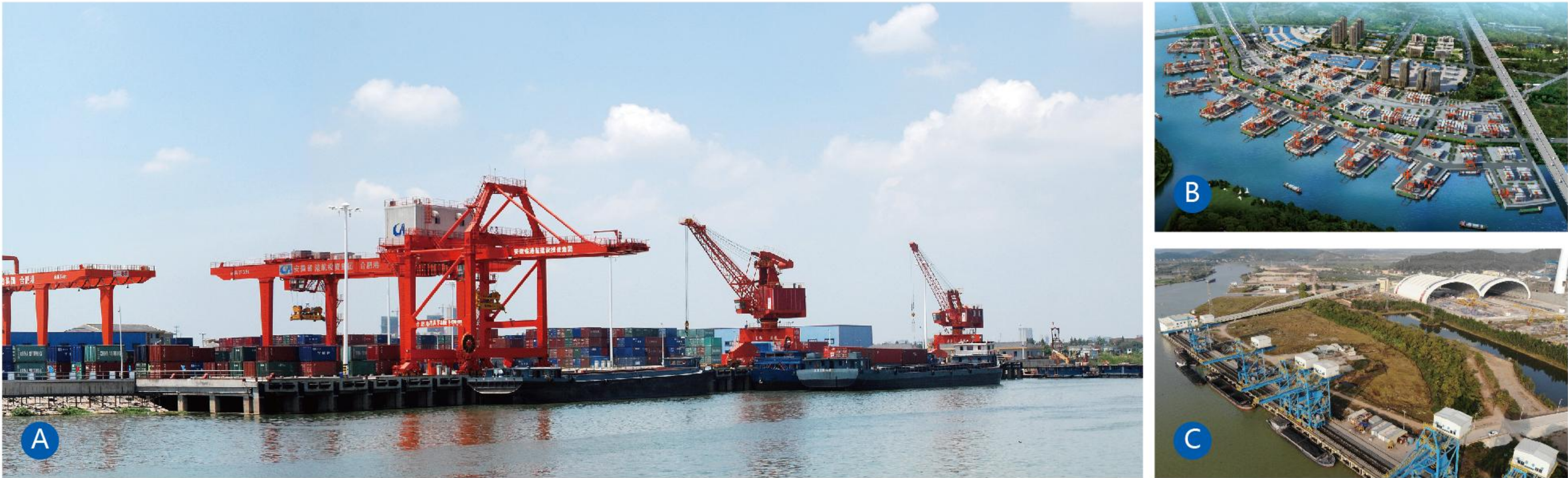
A、合肥港国际集装箱码头——中国水运建设行业协会优秀设计一等奖、全国36个主要内河港之一 B、河南周口中心港——河南省规模最大的内河集装箱港口 C、越南海阳燃煤电厂码头——一带一路项目、越南北部地区规模最大的内河码头
