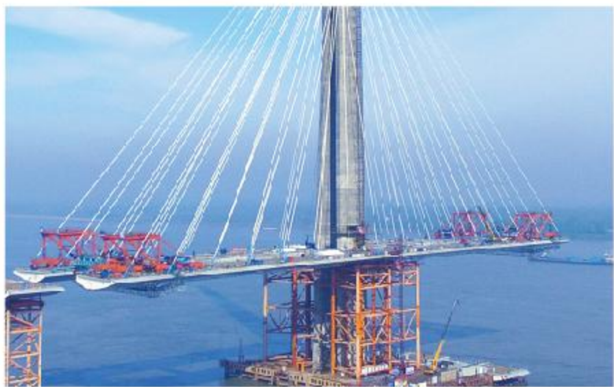
斜拉索桥同向回转拉索关键技术
