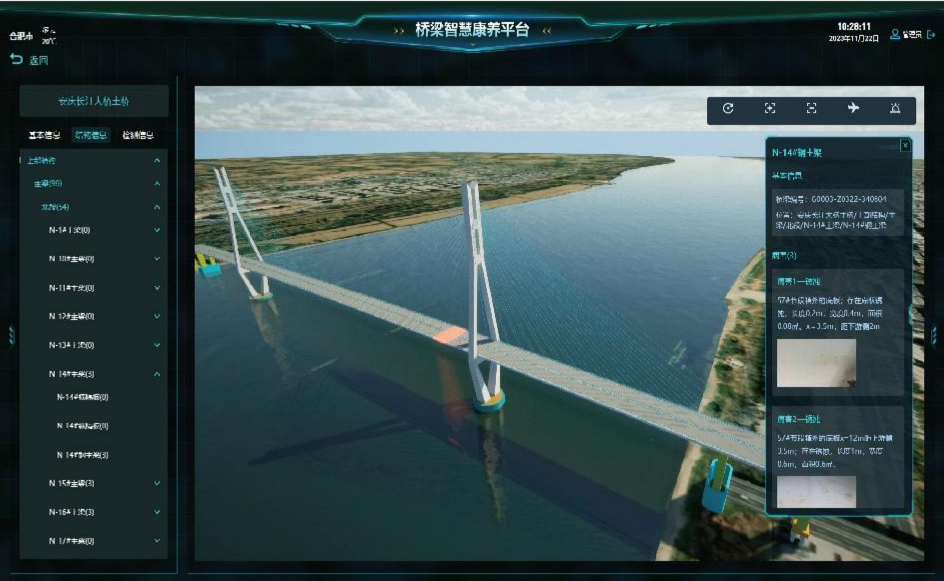
工程数字化集成养护平台（安庆长江大桥主桥）
