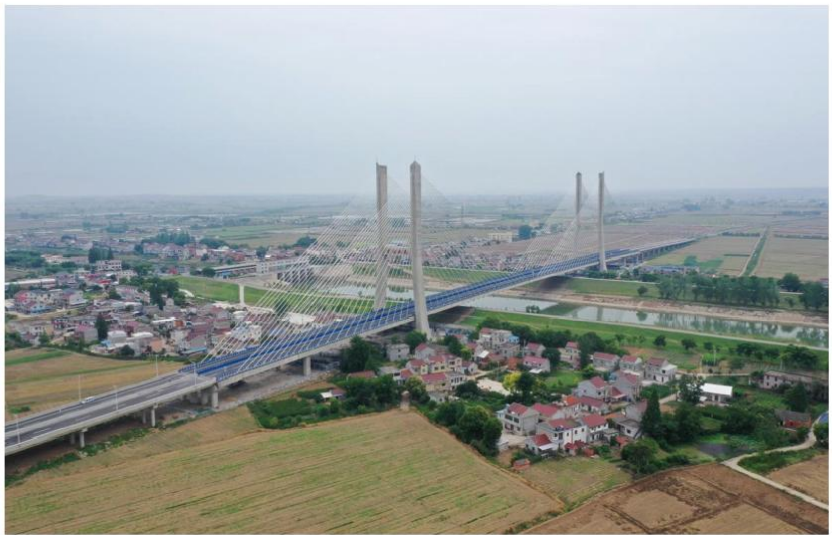
杨湾河特大桥交工通车
