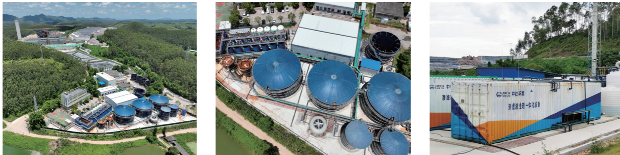
公司所属中铁环境研发的生活垃圾填埋场渗滤液全量化处理技术应用于台山项目。
