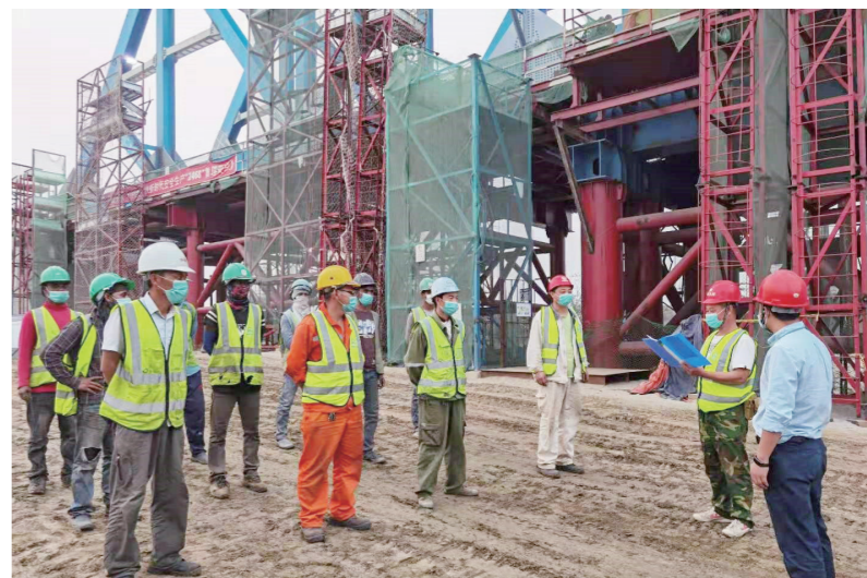
公司雇佣当地员工参与工程建设
