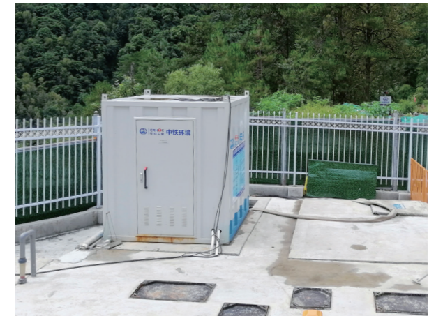
公司所属中铁环境研制的高原环境生活污水处理一体化设备。
