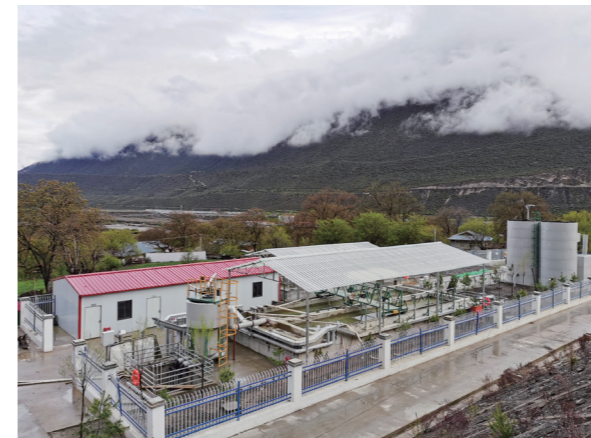
公司所属中铁环境研发的生活垃圾填埋场渗滤液全量化处理技术应用于台山项目。
