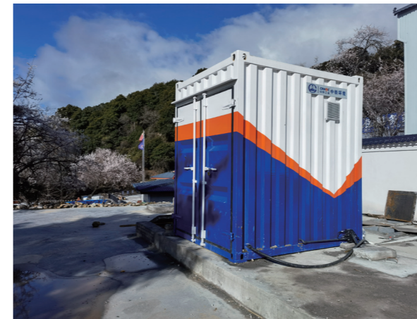
公司所属中铁环境研制的高原环境生活污水处理一体化设备。
