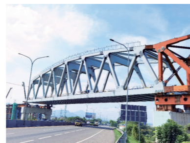
为印尼雅万高铁建造的84米钢桁梁
