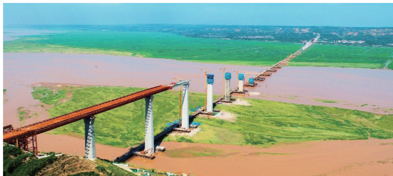
免涂装耐候钢应用于中铁九桥参建的临猗黄河大桥
