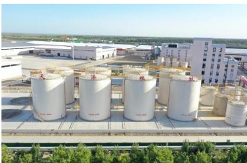
公司年处理 30 万吨油脂加工项目于 8 月底顺利建成试生产，10 月升为规模以上企业，12 月底达产。该项目采用先进的自动化控制设备、行业领先的技术，整体实现生产系统数据可视可控，采用前端预处理 60%棉籽蛋白的工艺，拥有自主知识产权，生产成本相对于同行业降低 10-15%。
