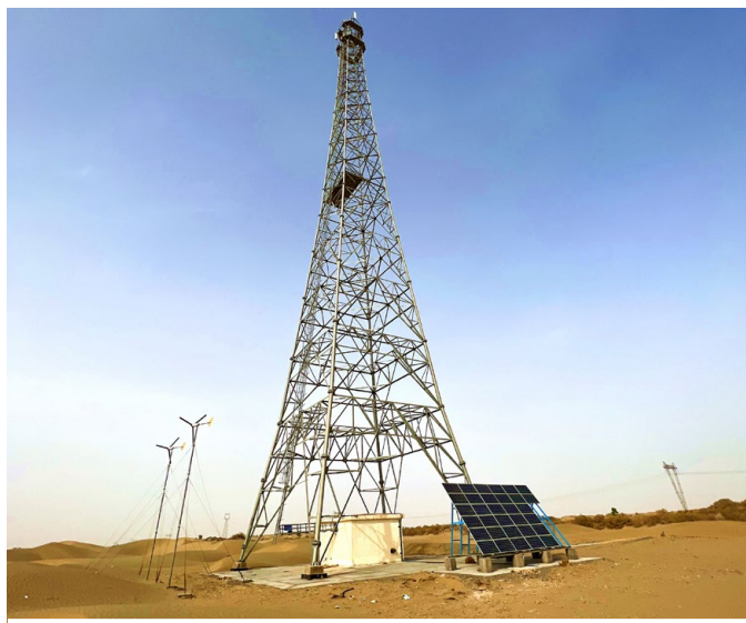
公司在新疆建设太阳能基站
