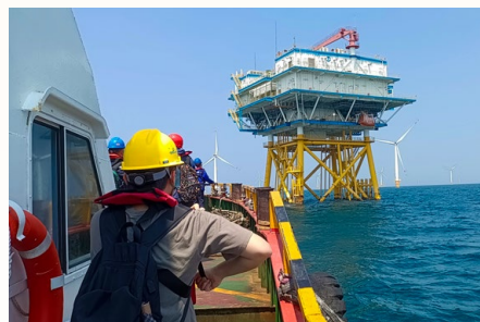
广东省阳江市海上风电平台 5G 基站建设
