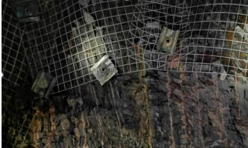
图 4-21 现采区凿岩进路掌子面矿体及锚网支护
