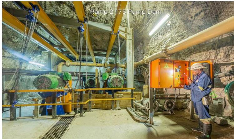
图 4-9 Ramp2 区域的 175mL 泵站
