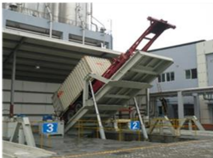
集装箱卸料实景图
