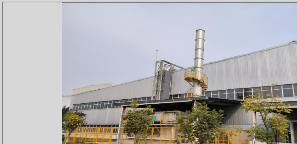
河北宝钢制罐蓄热式环保炉 RTO
