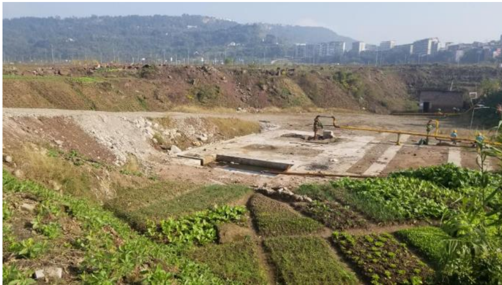
图：卤水管道输送实景图
