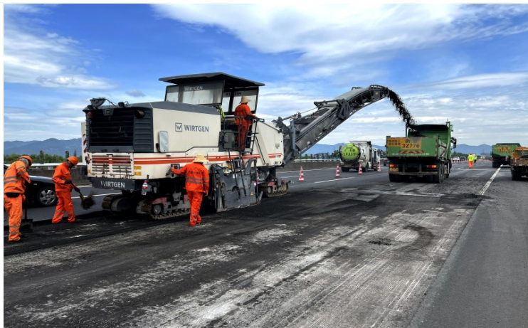
沥青工人们顶着烈日进行路面检测确保高速畅通
