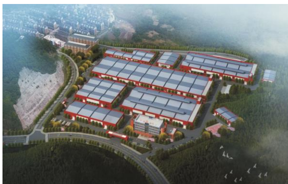
杭电股份控股的杭州千岛湖电线电缆产业园（杭州千岛湖永通电缆有限公司、浙江杭电永通线缆有限公司等）位于杭州市淳安县千岛湖镇，占地面积 170 亩，主要生产民用电线等。
