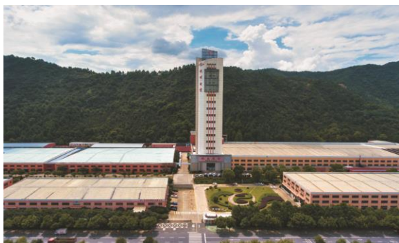
杭电股份电力电缆生产基地位于杭州市富阳经济技术开发区，占地面积 180 亩，主要生产 500kV 及以下中高压交联电力电缆。
