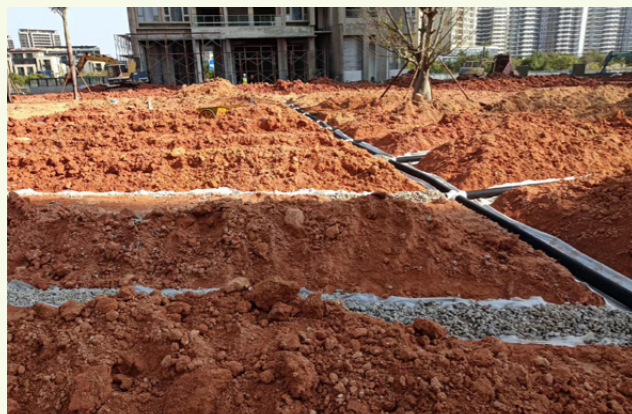
海绵城市滤水管布设
