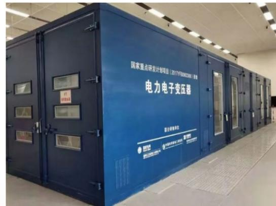
苏州同里综合服务能源中心的10kV/3MVA的四端口电力电子变压器
