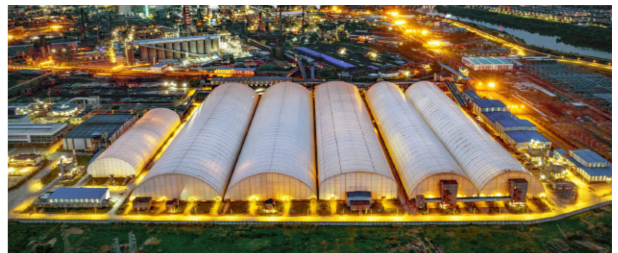
“智能综合料场”实现数字化操控，推进新钢无组织排放量每年减少 80% 以上
