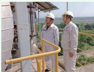
安全隐患排查
