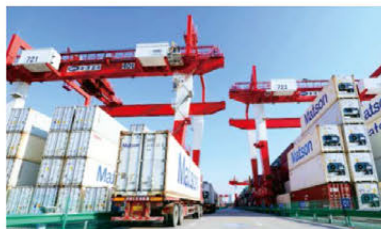
自动化重箱轨道吊
