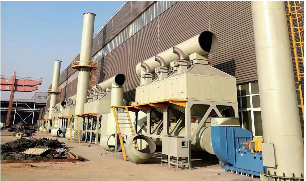
◎ 中铁山桥两个厂房进行 VOCs 治理，有效降低厂区 VOCs 的排放，改善大气环境质量
