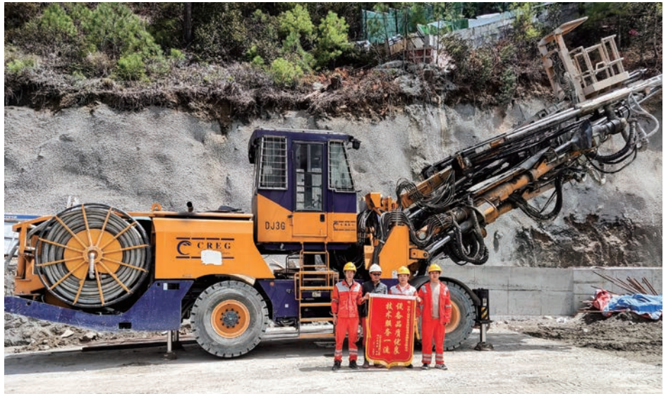
◎ 2022 年 4 月 22 日，中铁工业所属中铁装备高原铁路拉月隧道 7 号横洞凿岩台车服务班组收到项目部赠送表扬锦旗，优质产品和贴心服务受到客户肯定。
