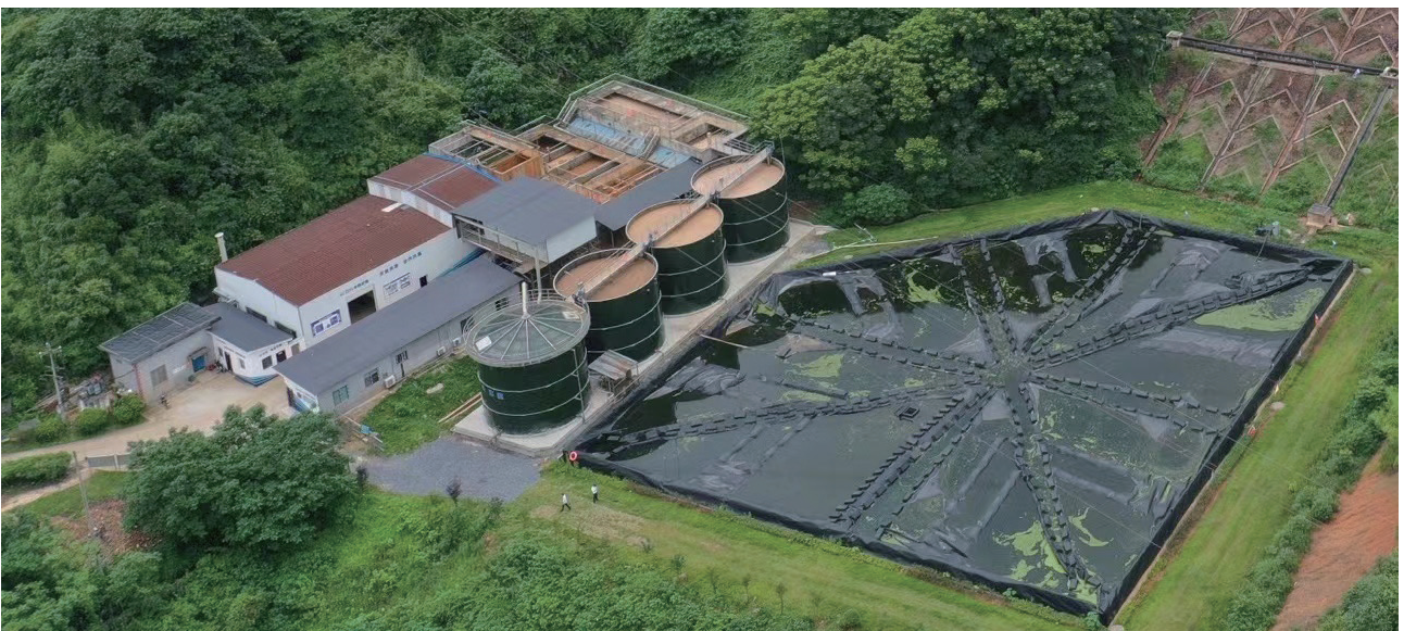
◎ 郴州市倒窝里生活垃圾填埋场应急抢险项目渗滤液处理运营
