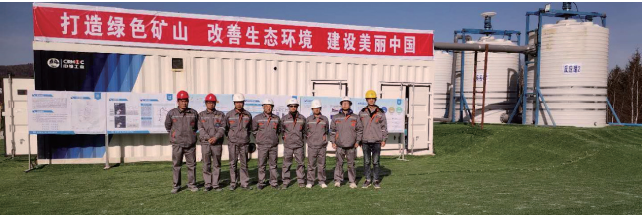
◎ 鹿鸣矿业项目排土场周边水处理设备
